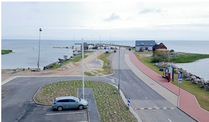
Vaade sadamale päästehoone õppeklassist. Suvised ehitustööd on alles ees
