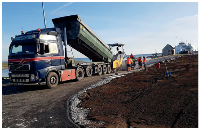
Väikelaevade kai juurdepääsutee asfalteerimine
