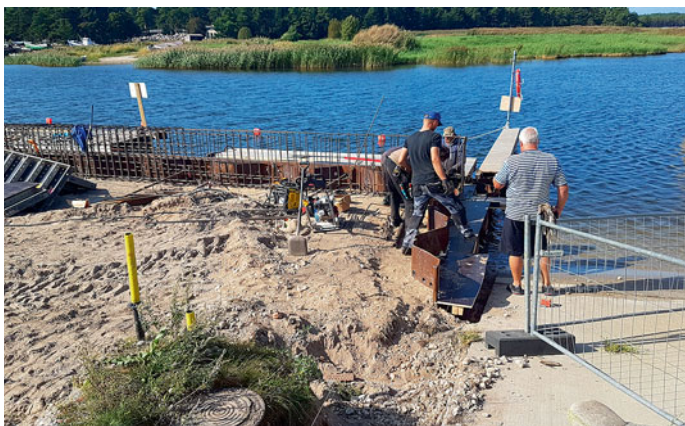
Betoonosa valmimine oli ajakriitiline ning mehed pingutasid kõvasti, et augusti lõpuks valmis saada. Tublid!
